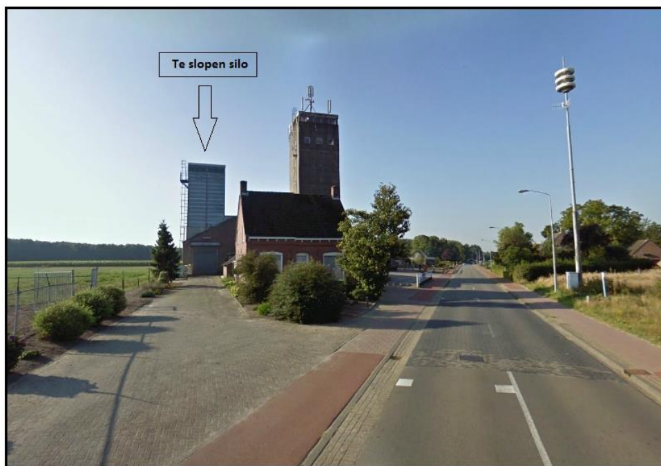
Figuur. Te slopen silo
