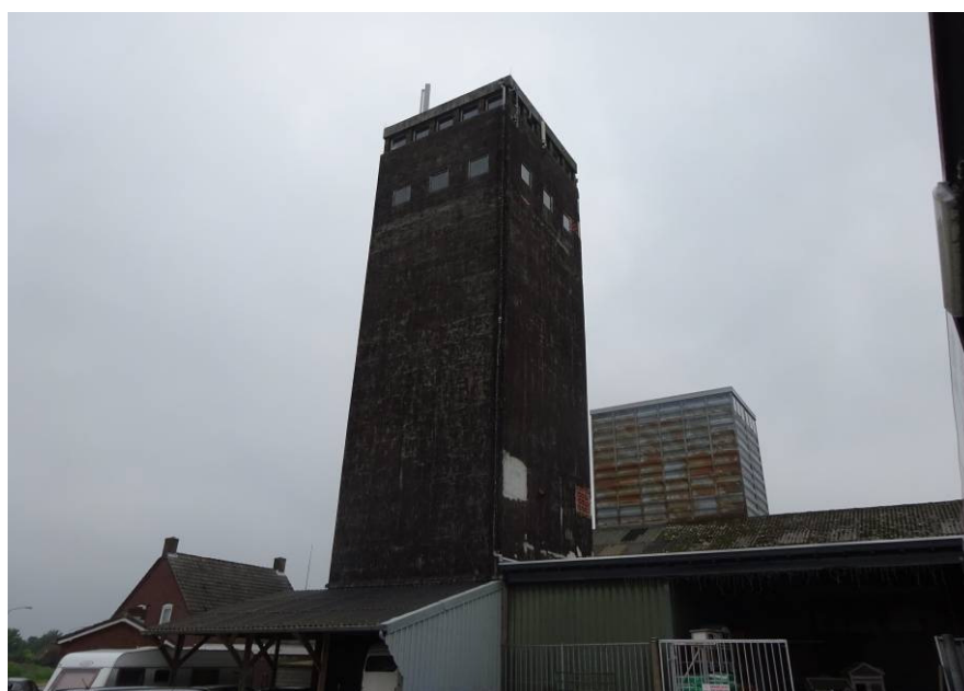
Afbeelding 07- Het silo-gebouw in zijn huidige toestand, juli 2014.
