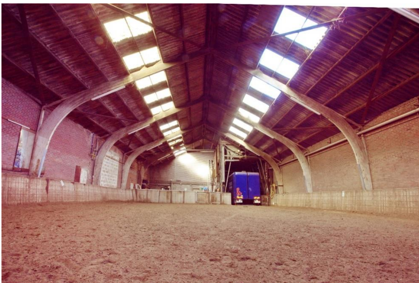
Figuur 3: Loods met dressuurbak
