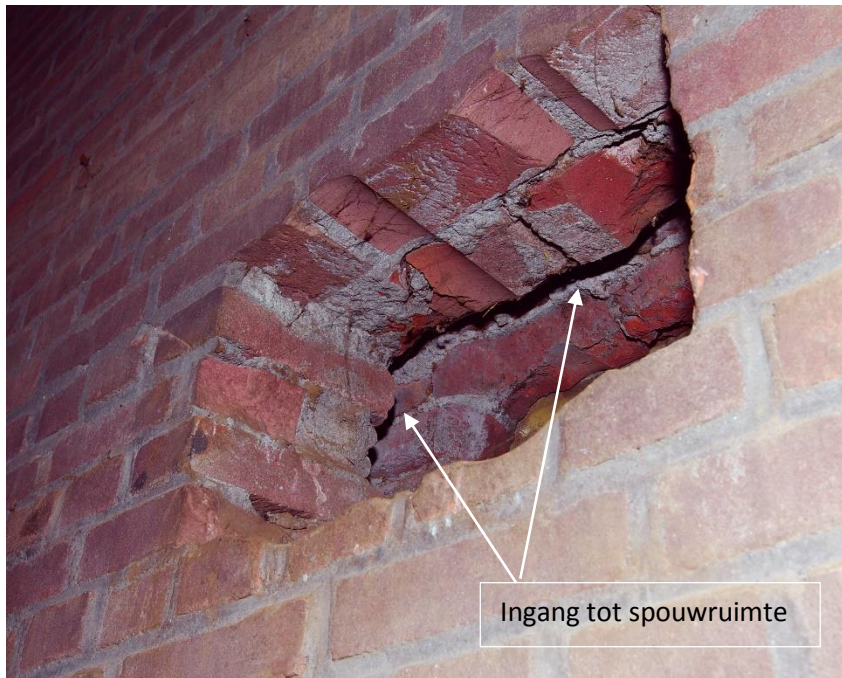
Figuur 8: Ventilatie gat met vleermuis faciliterende werking.
