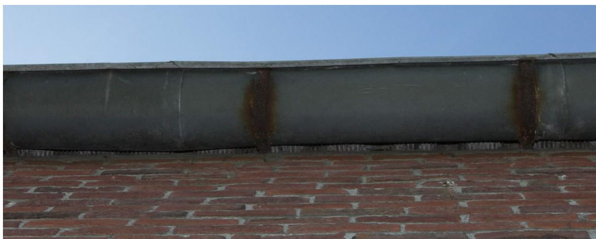
Bijlage 2: Vogelwerende constructie onde golfplatendak
